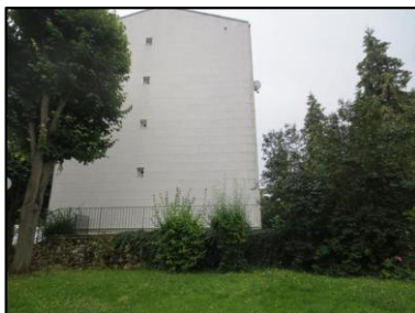
Photo N° 1123 ECH-N°02 --facades Murs bardages sur pignons
